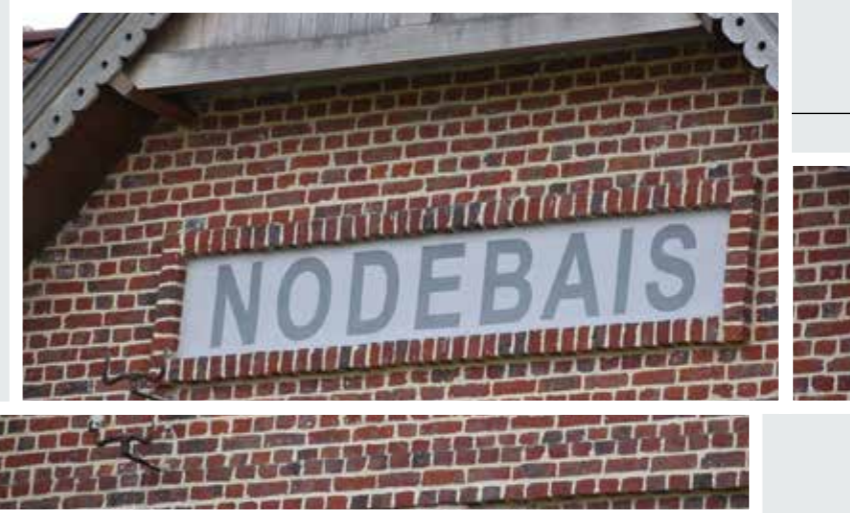
Enseigne de la station du vicinal
