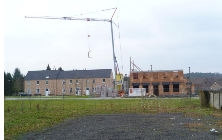
Construction de logements publics sur le site de l'ancien lycée de Hamme Mille
